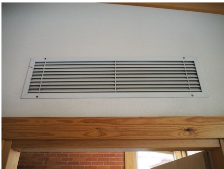
1-2. Tuloilmasäleikköjä. 3. Poistoilmaventtiileitä. 4. Vapaavirtaussäleikkö. 6. Paneeliradiaattori. 7. Valokatkaisija.
